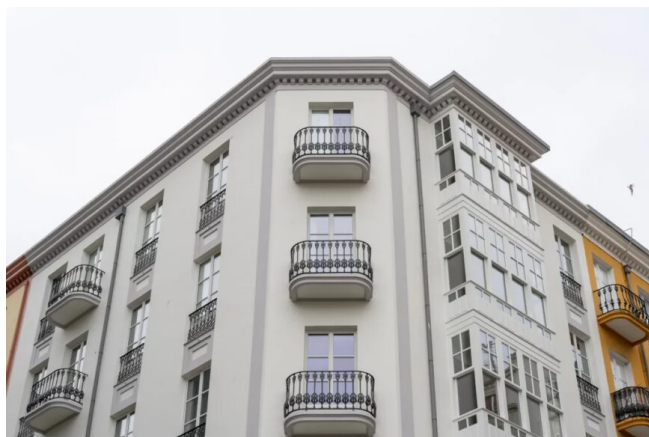
Rehabilitación de un edificio de 5 viviendas en A Coruña
