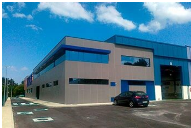
Ampliación de nave para ITV en Sada
