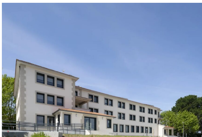
Rehabilitación de residencia de mayores en Oleiros
