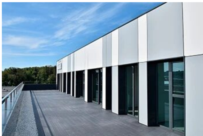
Reforma de espacio para oficinas en Oleiros
