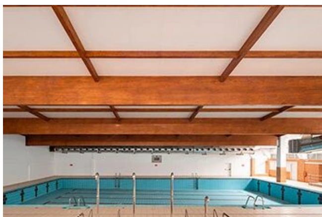
Reforma de cubierta de piscina de Riazor en A Coruña
