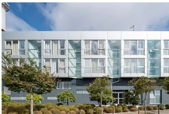
Reforma de residencia para mayores en Santiago de Compostela
