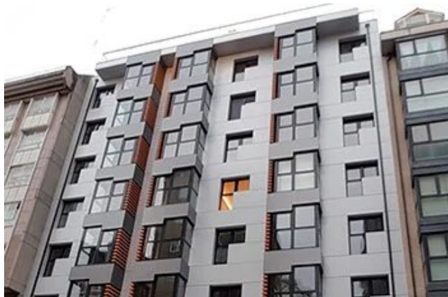
Edificio de 18 viviendas en A Coruña
