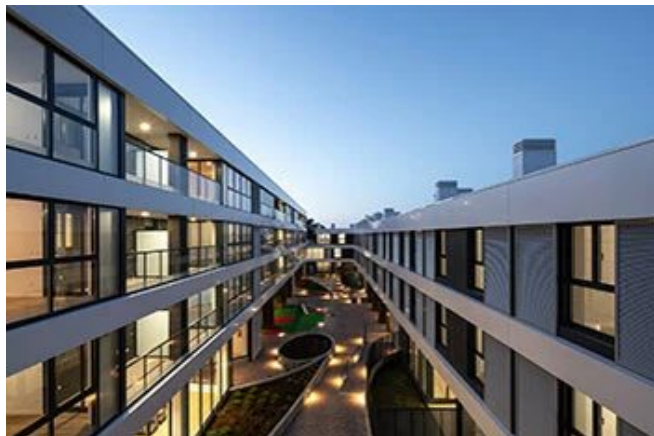
Edificio de 46 viviendas con trastero, garaje y zonas comunes en Oleiros
