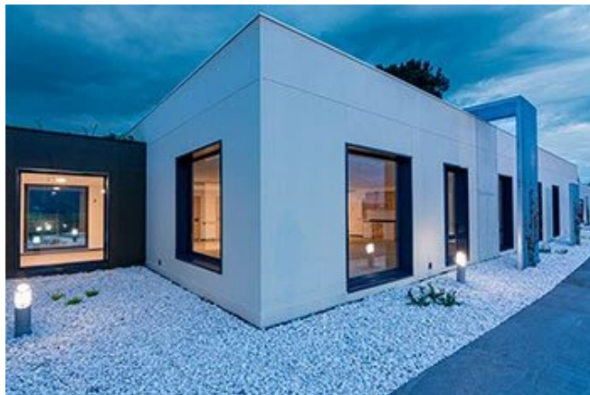
Construcción de residencia para mayores en Sada
