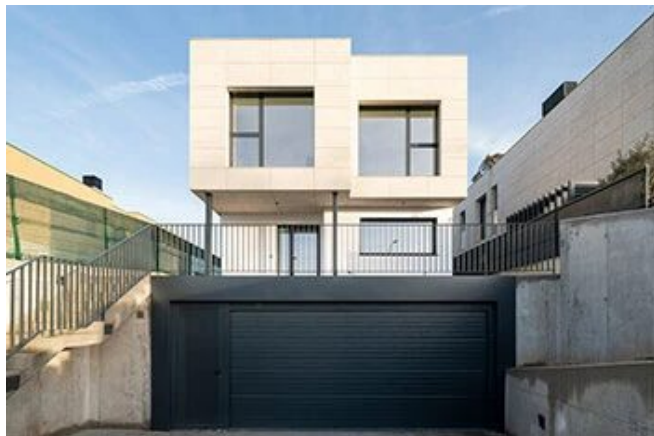
Vivienda unifamiliar en Oleiros
