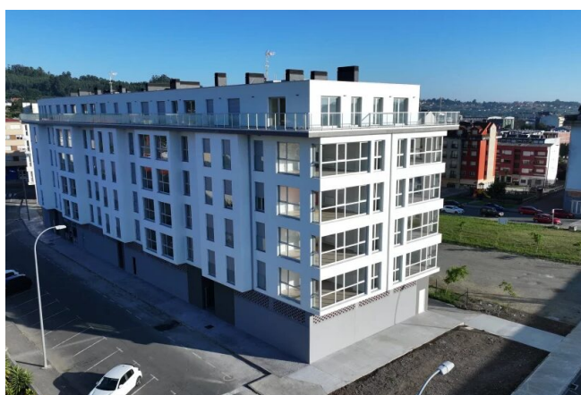
Edificio residencial de 57 viviendas, garaje y locales en Carral
