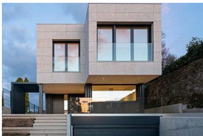
Vivienda unifamiliar en Oleiros
