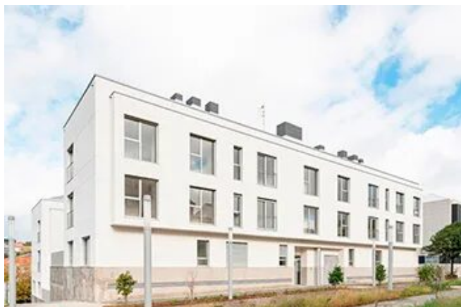
Edificio de 24 viviendas con garajes y trasteros en Santiago de Compostela
