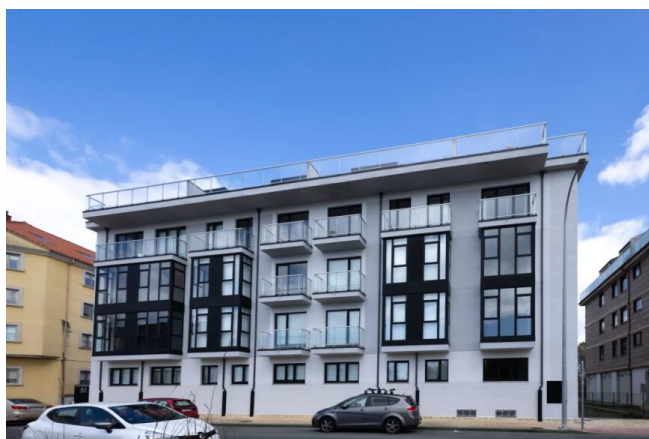
Edificio de 42 viviendas, garaje y trasteros en Ares
